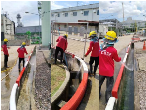
รูปที่ 22 การขุดลอกตะกอนในรางระบายน้ำ
