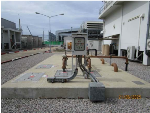
รูปที่ 5 บ่อแยกน้ำ-น้ำมัน (Oil/ Water Separator)
