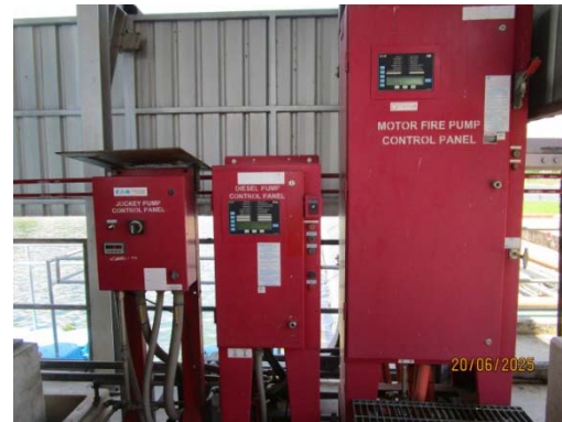
รูปที่ 41 ระบบปั้มน้ำดับเพลิง
