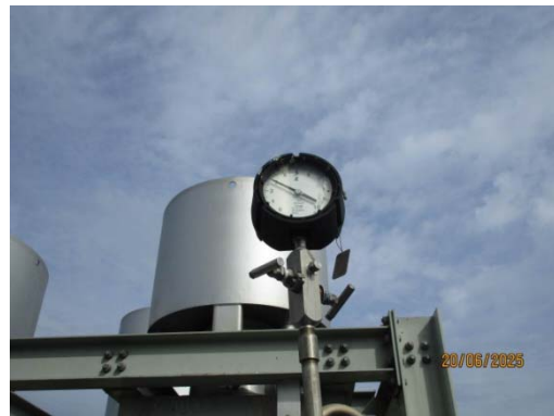
รูปที่ 51 มาตรวัดความดันไอน้ำที่หม้อไอน้ำ
