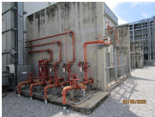
รูปที่ 33 ระบบฉีดพ่นน้ำ
