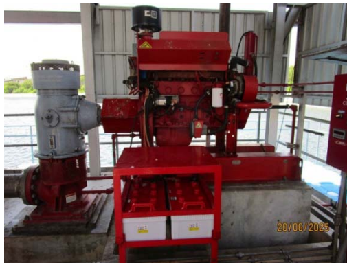
รูปที่ 41 ระบบปั้มน้ำดับเพลิง
